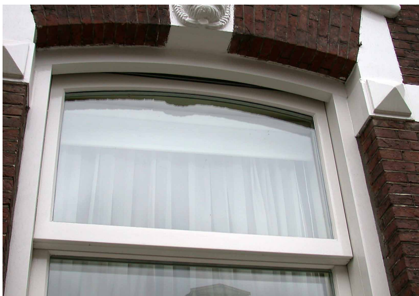
Foto voorzijde De vensters van dit voormalige bakhuis zijn geïsoleerd door achterzetbeglazing aan te brengen. Dit is zo uitgevoerd dat de karakteristieken van het stalvenster niet aangetast zijn en er ventilatie mogelijk is gebleven
