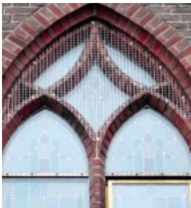
De raamkop van dit venster is voorzien van roestvast gaas om nestelen van vogels te voorkomen
