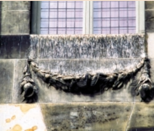
Detail van het Paleis op de Dam: het resultaat van het voeren van de duiven tekende zich voorheen af op de onderdorpels van de ramen. Inmiddels zijn er maatregelen getroffen, waardoor dit beeld tot het verleden behoort
