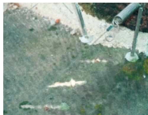
Resultaat van in het verleden aanbrengen van pennen in natuursteen. De pennen zijn recent verwijderd met een slijpschijf. Daardoor is er schade aan de natuursteen ontstaan. Bovendien zitten de pen-restanten nog vast in de steen. De pennen zijn vervangen door afgeveerde draden, waarvoor weer nieuwe gaatjes in de steen zijn geboord
