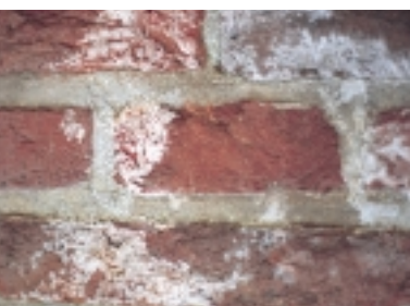
Detail van de drogende muur
