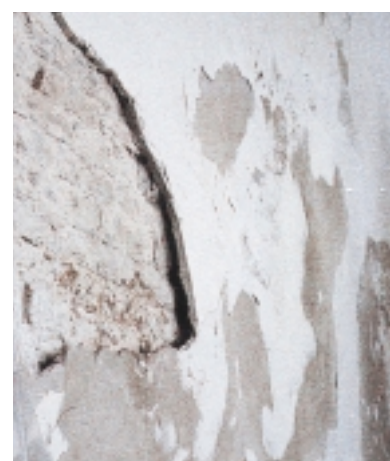
Loskomend pleisterwerk als een gevolg van volumevermeerdering door vocht en zouten (foto Koning & Bienfait)
