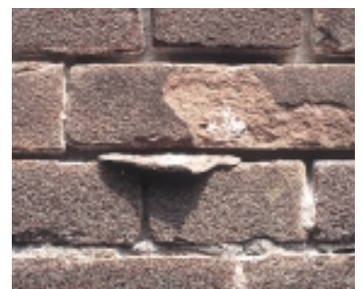
Losgelaten baksteenschilfer als gevolg van kristallisatie (foto M. van Rooden)
