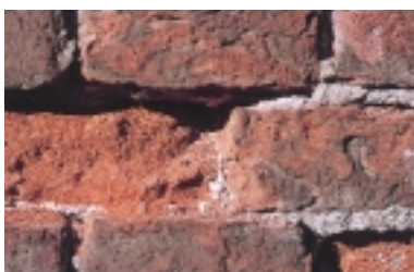
Afpoederende steen door droging, gepaard gaand met kristallisatie van zout. Er zijn witte zoutkorrels in de rode baksteenpoeder zichtbaar (foto M. van Rooden)
