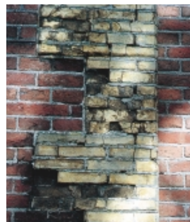
Schade als gevolg van de kristallisatie van zouten. De gele stenen blijken gevoeliger dan de rode stenen. Een voorbeeld van verschil in poriëngrootte van het materiaal (foto Koning & Bienfait)
