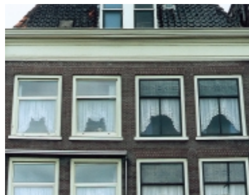
Architectuur verstorende vervanging van schuiframen
