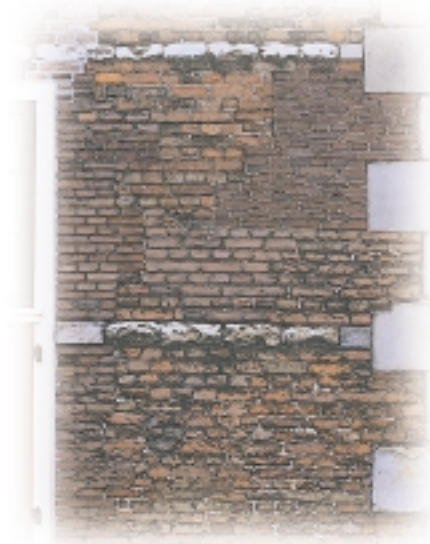
Verscheidene inboetingen en zeer verschillende kwaliteiten baksteen.
