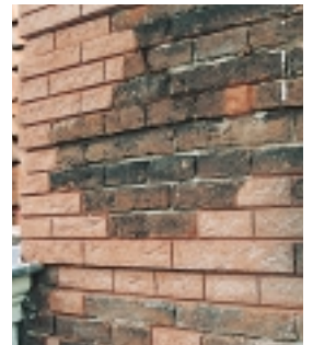
Gerepareerd gedeelte van één der gevelpenanten.
