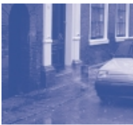
Passerend verkeer zorgt voor het opspatten tegen de monumentale gevel.
