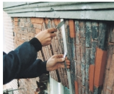
Reparatie van de hoge strek boven het venster. De staande voeg wordt ingesneden.
