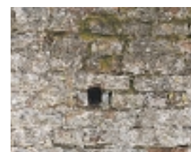
Alg- en mosvorming op zwaar vochtbelaste muur.
