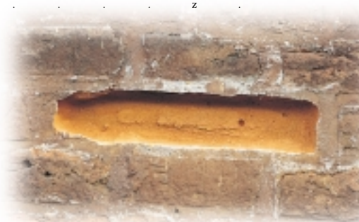
Versnelling van het proces van afbraak van een baksteen met beperkte kwaliteit door aan- wezigheid van de cementvoeg.
