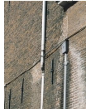
Overmatige toevoer van vocht door gebreken aan de hemelwaterafvoeren.
