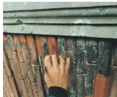
De steenstructuur wordt met behulp van een spatel ingebracht.
