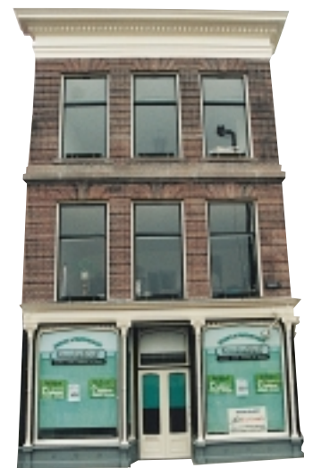
De voorgevel na reparatie met reparatiemortel in oude luister hersteld.
