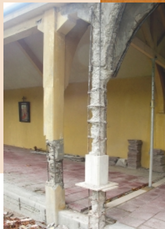
Een deel van de betonnen omgang van de Bedevaartskerk in Brielle uit 1932 tijdens de uitvoering van een proefproject voor herstel
