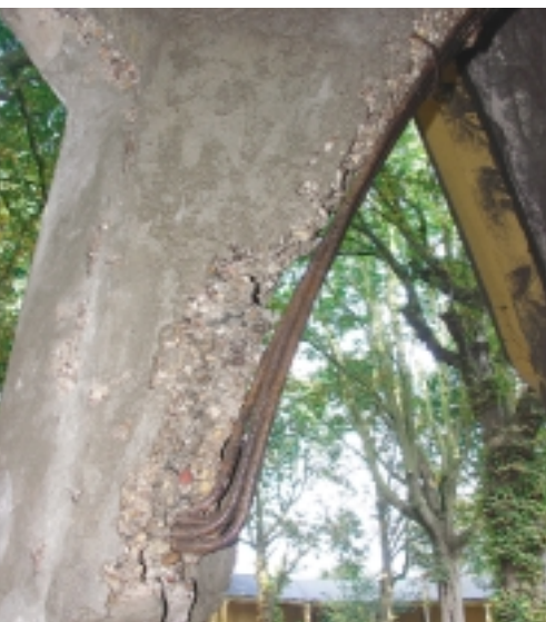
Ribbe van een van de gewelven van de betonnen omgang van de Bedevaartskerk in Brielle. Met water onder zeer hoge druk is het beschadigde beton verwijderd, om zo de ondergrond geschikt te maken voor herstel
