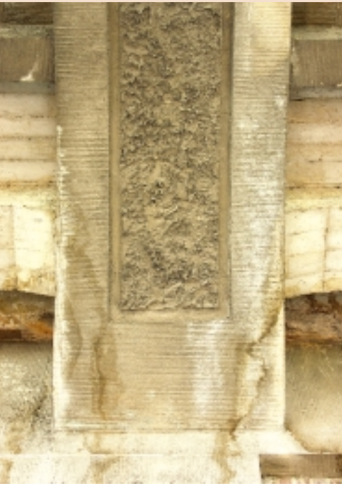
Console onder een laadperron van het voormalige pakhuis Sint-Jobsveem in Rotterdam uit 1912. Een deel van het beton is afgewerkt met een stuclaag, die een gekamd en bruut opperlak heeft. Met cementpleister is het gefrijnde zandsteen van de voorgevel kunstig geïmiteerd op de achtergevel
