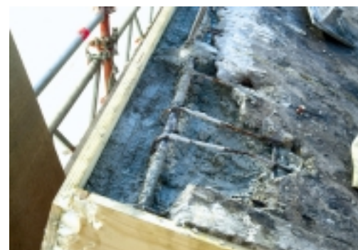
Herstel van hangend werk met behulp van een open bekisting. De aangetaste wapening is vervangen door een nieuwe wapeningsstaaf
