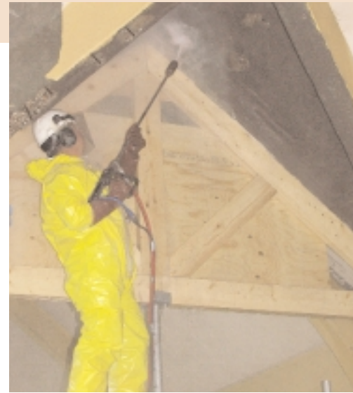
Saneren van beton met water onder zeer hoge druk, tussen de 1000 en 2000 bar
