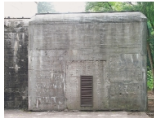
Bij herstel van de bunker Diogenes in Schaarsbergen uit 1943 is gebruikgemaakt van bekisting van ruw houten delen. Oppervlaktestructuur en vorm voegen zich daardoor redelijk met het oorspronkelijke uiterlijk
