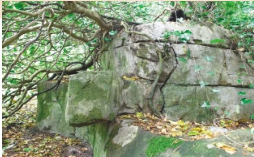
Cementrustieke imitatierotsen uit het begin van de twintigste eeuw. De dunwandige constructie, bestaande uit kippengaas met cementmortel, is opvallend duurzaam gebleken. Toch bedreigen wortelgroei, verzakkingen en vorst het voortbestaan ervan
