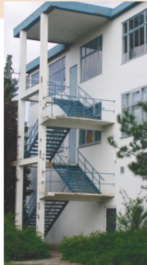
Deel van de Schoenfabriek Bata in Best, een functionalistisch bedrijfsgebouw uit 1934.
