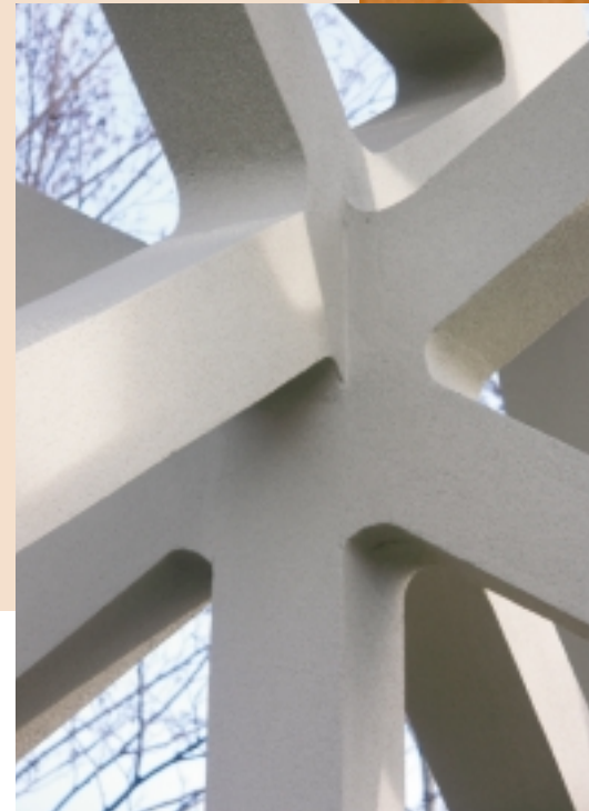
Plastisch vormgegeven detail van de vroeg-twintigste-eeuwse klokkenstoel in Gersloot. De vormgeving is kenmerkend voor gegoten kunststeen, zoals beton
