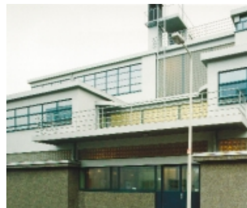
Voorzijde van de Derde Ambachtsschool van Jan Duiker in Scheveningen na restauratie.
