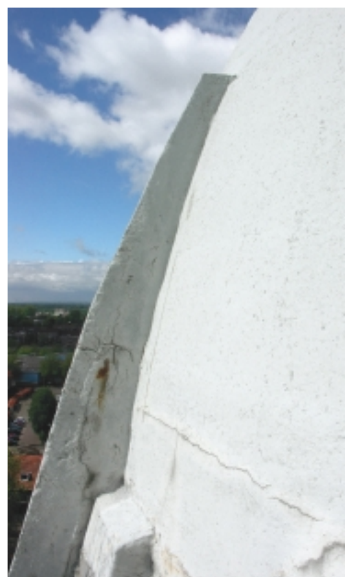
Detail van de betonnen koepel van de watertoren in Zutphen. De slechte bereikbaarheid en de materiaalkundige problemen vragen om een verfsysteem dat scheuroverbruggend is en een lange levensduur heeft
