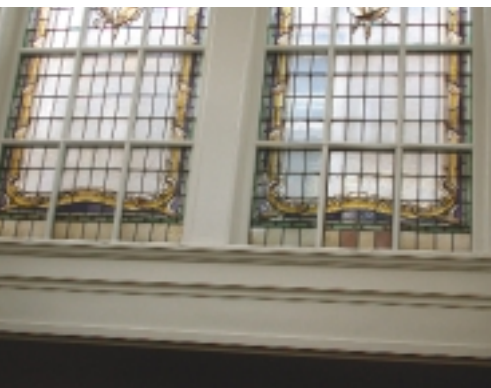
Detail van een groot glas-in-loodraam, waar de panelen zijn opgenomen in een houten raamwerk
