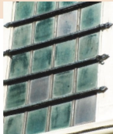
Glas-in-lood in een houten raam, met ter plaatse van elke horizontale loodlijn een windroede
