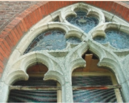
Bovenzijde van een venster, waaruit glas-in-loodpanelen voor restauratie tijdelijk verwijderd zijn. Onderaan zijn twee brugstaven te zien, die de raamopening overspannen en de montants op hun plaats houden
