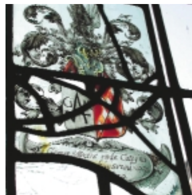
Gebrandschilderd glas waarin storend breukloodjes zijn gezet
