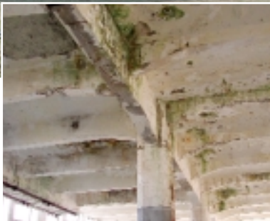
De Spoelery van de Tricot-fabriek in Winterswijk, die is gebouwd tussen 1912 en 1922. Het is een vroeg voorbeeld van een gebouw met betonskelet. Karakteristiek zijn de consoles in de vorm van een afschuining bij de aansluitingen van balken
