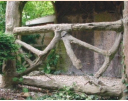
Cementrusterij priefel, uit circa 1892, dat onderdeel uitmaakt van de tuin van het Snouck van Loosenhuis te Enkhuizen. Het is opgebouwd uit een stalen frame en cementmortel. Wat materiaalproblematiek betreft, vertoont dit type constructie veel overeenkomsten met gewapend beton
