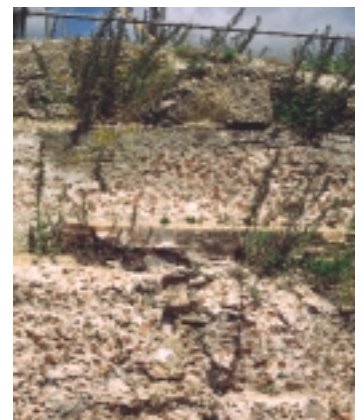
Beton van het oudste deel van het forteiland bij IJmuiden, dat is gebouwd omstreeks 1890. De doorsnede toont verschillende soorten beton, met bovenop een laag gewoon beton en daaronder brikkenbeton (foto Gert Jan Luijendijk)
