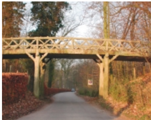
Cementrustieke brug op het landgoed van kasteel De Haar bij Utrecht
