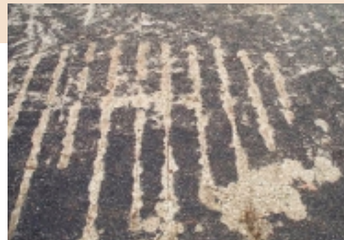
Afschilfering van dit donker gekleurde betondek wordt veroorzaakt door inwerking van vorst, in combinatie met dooizouten (foto C. van der Steen, Technoconsult, Heeswijk)
