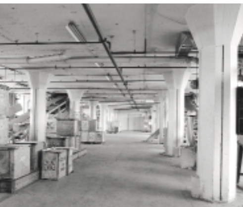
De Spoelery van de Tricot-fabriek in Winterswijk, die is gebouwd tussen 1912 en 1922. Het is een vroeg voorbeeld van een gebouw met betonskelet. Karakteristiek zijn de consoles in de vorm van een afschuining bij de aansluitingen van balken
