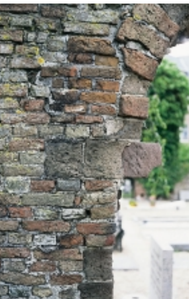
Metselwerk van baksteen en tufsteen in onregelmatig verband en formaat. Wil het herstel verantwoord plaatsvinden, dan is voorafgaand fotografische opname noodzakelijk
