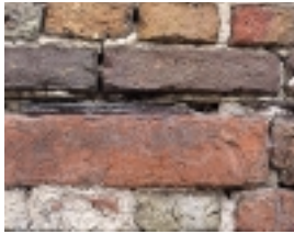
Een bouwhistorisch aspect van metselwerk: de aanwezigheid van leisteen in de voeg
