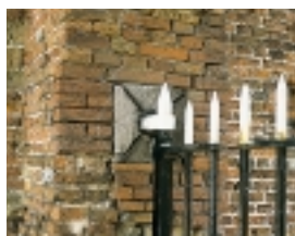
Scheuren ten gevolge van roestend ijzer
