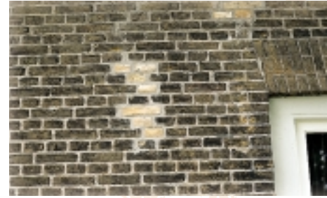
Bescheiden inboetwerk in een gevel
