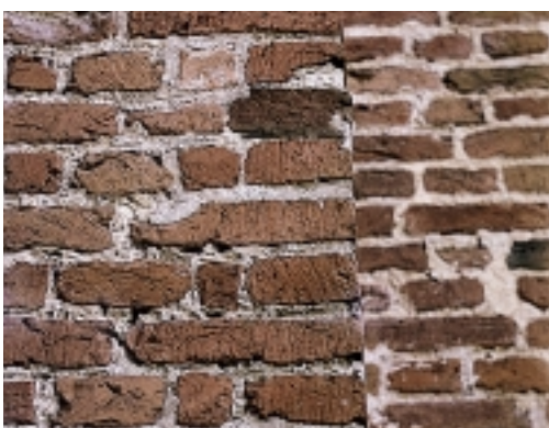
Detail van een steunbeer met verfijnde afwerking, door scharreren verkregen. Klezoor in koppenlaag
