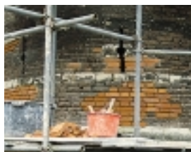
Inboetwerk in uitvoering (foto gemeente Haarlem)
