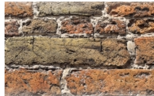
Detail van een torenwand in kloostermop en Rijnsteen, gemetseld in kalkspecie
