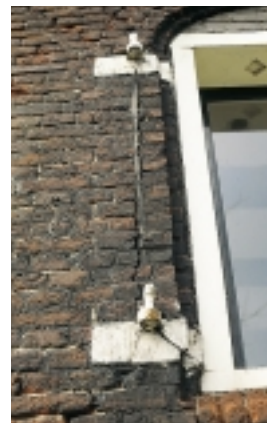
Scheur ten gevolge van roestende duimen
