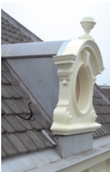
Bij deze oeil-de-boeuf is ter weerszijden een ladderhaak aangebracht om de goot veilig te kunnen inspecteren en schoon te maken
