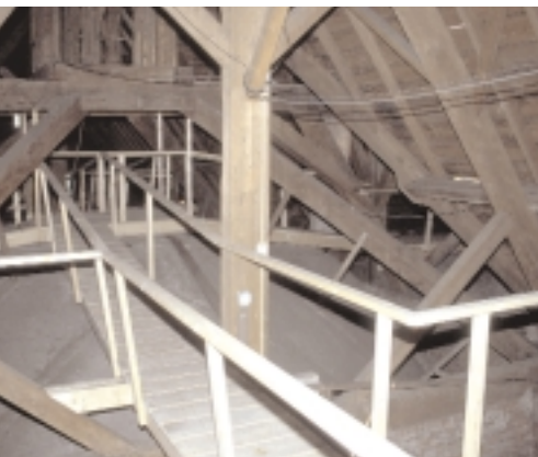
Zorg bij het maken van restauratieplannen dat in grote kappen deugdelijke loopbruggen worden aangebracht
