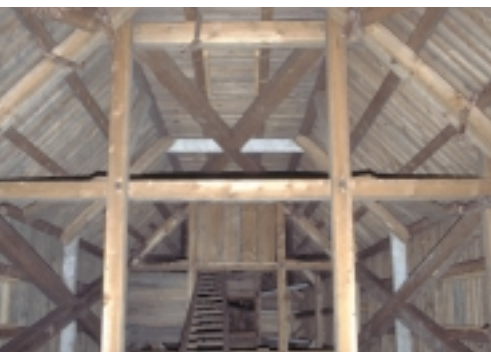
Bij torens is het belangrijk om per tafelment een vloer aan te brengen
