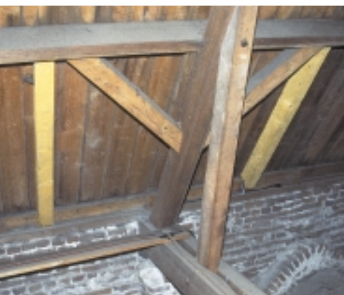
Een deugdelijke bevestiging van ladderhaken is essentieel. In dit geval zijn hiervoor aan de binnenzijde van de kap aparte balkjes tussen de gordingen aangebracht
