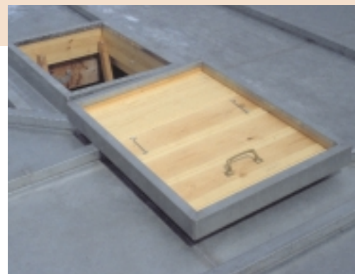
Ook platte daken en zinken roevendaken kunnen het beste toegankelijk gemaakt worden door middel van luiken
