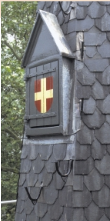
Bij luiken dienen de klimhaken – zoals hier – aan de sluitzijde van de dakkapel aangebracht te worden
