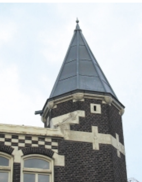
Een zinken roevendak. De roeven vormen hier tegelijk de hoekkepers
