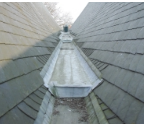
Broekstukken en hemelwaterafvoeren zijn niet altijd mogelijk. Om de lengte van de gootdelen toch te beperken wordt een cascadegoot gemaakt. De getrapte vorm bevordert bovendien de snelle afvoer van water
