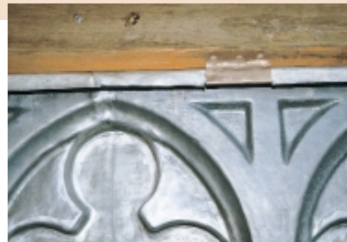
Detail van een met lood beklede toren. De platen lood zijn met een koperen klang aan het hout bevestigd. Links, dwars over de top van de driepas, zijn twee platen lood aan elkaar gelast. Het lood is deels in de onderliggende houten vorm geklopt, deels opgebouwd uit verschillende stukken, die aan elkaar zijn gelast
