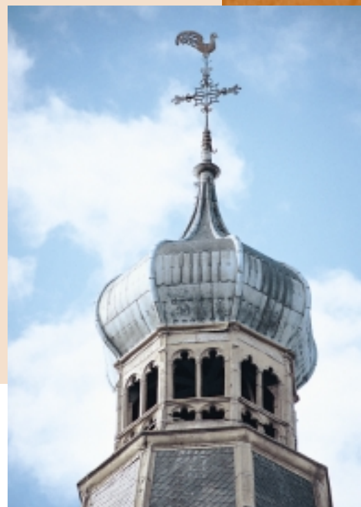
Karakteristiek gebruik van lood sinds de 16de eeuw: bekleding van een torenspits. Met de gebroken witte verf heeft men natuursteen (zandsteen) willen suggereren
