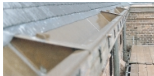
Koperen goot opgedeeld met broekstukken om uitzetting van het metaal mogelijk te maken
