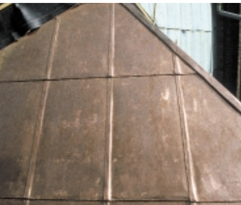
Detail van een koperen felsdak. De platen zijn verticaal verbonden met staande felsen (foto boven) en platte felsen (onder) en horizontaal met aanbaken
