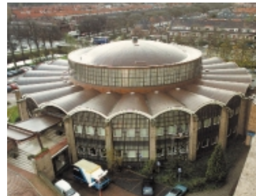
Het ANWB-kantoor in Den Haag, in oorsprong voorzien van een Tecuta dakbedekking, recent gerestaureerd met een gelijksoortige dakbedekking op basis van een thermoplastische onderlaag met een koperen topplaat (foto: Van Det Foto-producties, Vlaardingen)
