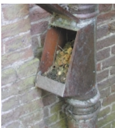
Bladopvangrooster in een koperen hemelwaterafvoer. Effectief en het voorkomt schade aan afvoer en bovenliggende goot door verstopping
