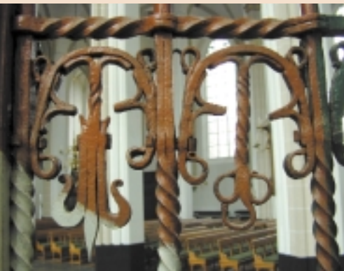
Smeedwerk in 1516 gemaakt door Jan van den Ende in de Andreaskapel van de Buurkerk te Utrecht, gepolychromeerd rond 1600. Aangevelde toten en krullen, klinknagels, liggers en doorgestoken spijlen die zijn samengesteld uit vier staafjes en vervolgens getordeerd. De bladeren van de lelie zijn aan elkaar geklonken met een klinknagel
