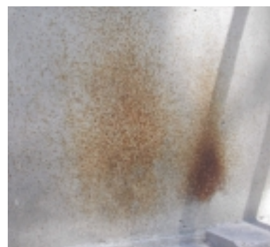
Tijdens het slijpen van ijzer met een slijpschijf verspreiden zich metaalsplinters. Deze branden zich vast in het oppervlak van natuursteen en gaan daar vervolgens roesten. De (natuursteen) omgeving moet dus afgedekt worden wanneer men gebruikmaakt van de slijpschijf
