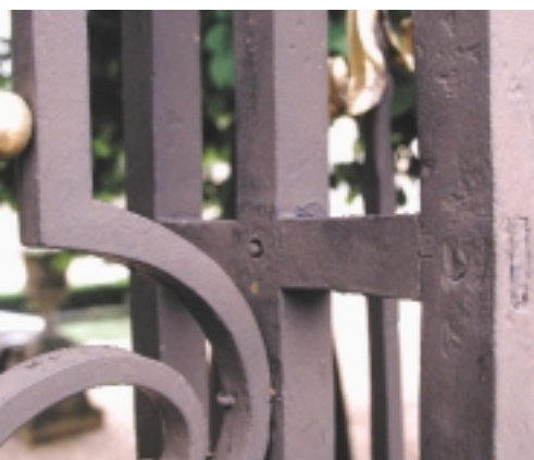
Pen- en gatverbinding: de vierkante pen (revet, rivet) is in de stijl van het hek gestoken en vastgezet met een kleinere ronde pen (foto E.J. Nusselder)
