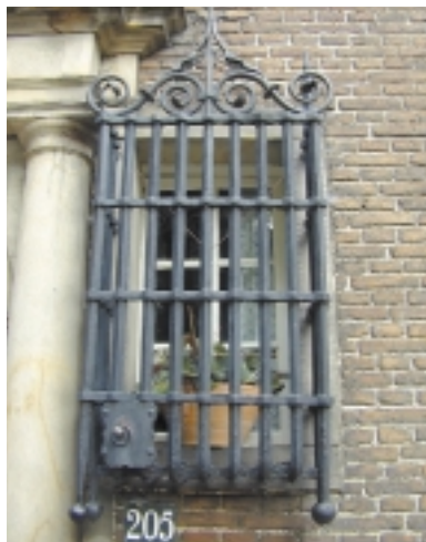
Zeventiende-eeuws smeedwerk aan de Nieuwegracht te Utrecht. De gaten voor de vierkante spijlen zijn door de vierkante liggers geslagen, waardoor deze op de plek van het gat zijn verbreed. Met een beitel zijn in de onderste gedeeltes van de spijlen hokkels geslagen. De bekroning is gemaakt van ronde staven, de bladeren zijn aangeveld. De krullen zijn in het midden verbonden door een gesmede band
