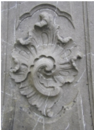
Hardsteen valt op den duur uiteen door steekvorming. Met wit krijt is hier het stekenpatroon verduidelijkt op een deel van een 250 jaar oude bepijler van buitenplaats Vredehoff te Loenen a/d Vecht
