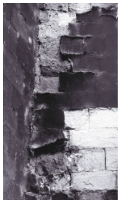
Pas na verloop van tijd worden de dramatische gevolgen van een verkeerde behandeling zichtbaar
