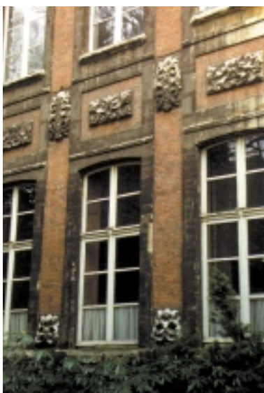
Voorbeeld van expositie van Ledesteen: de voor- (boven) en achtergevel (onder) van hetzelfde gebouw. De voorgevel bevindt zich aan de regenkant. Hier spoelt de steen schoon. De achtergevel bevindt zich in de luwte. Hier ontwikkelt zich een zwarte gipskorst op de steen
