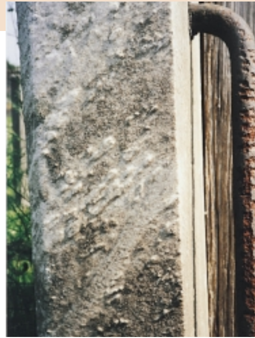
Het oppervlak van wit marmer lost in de loop der tijd op, waardoor hardere delen van de steen hoger komen te liggen
