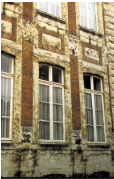
Voorbeeld van expositie van Ledesteen: de voor- (boven) en achtergevel (onder) van hetzelfde gebouw. De voorgevel bevindt zich aan de regenkant. Hier spoelt de steen schoon. De achtergevel bevindt zich in de luwte. Hier ontwikkelt zich een zwarte gipskorst op de steen
