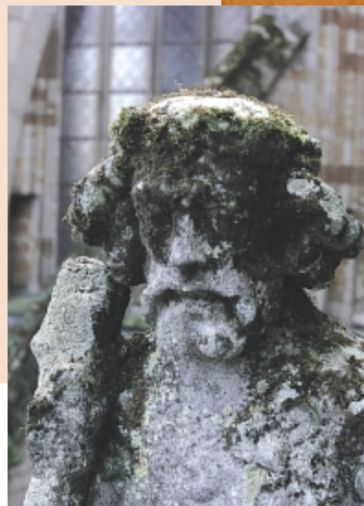
Dit tufstenen beeld staat aan de noordzijde van de St. Janskathedraal in Den Bosch en blijft lang vochtig; een ideale voedingsbodem voor mossen
