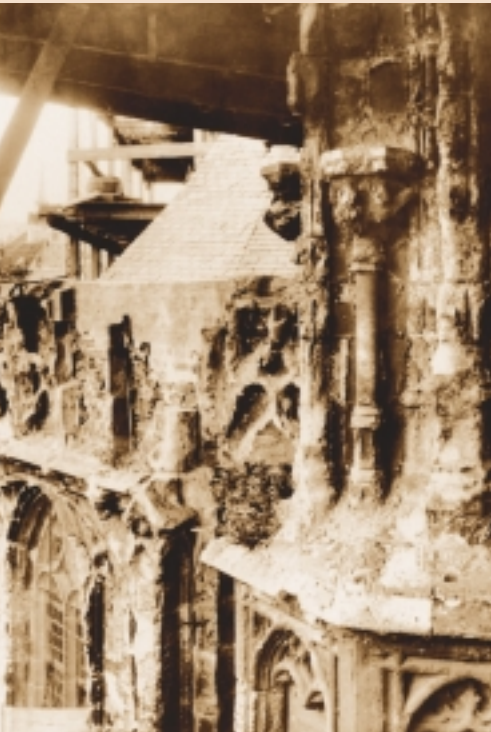
Gedeelte van de St. Janskerk in Den Bosch vóór de restauratie in de jaren '30 van de vorige eeuw: grotendeels nog in sterk verweerde Lede-steen (herkomst foto: archief St. Jan)
