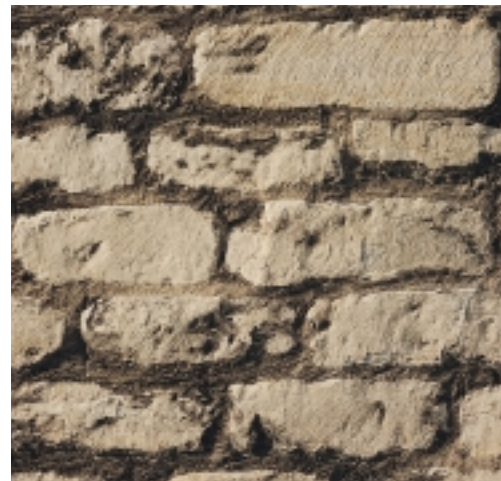
Opname van zogenoemd paramentwerk, uitgevoerd in Gobertanger kalksteen
