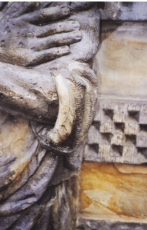
Detail van de trap van het stadhuis te Gouda, uitgevoerd in zandsteen (foto: H.J. Tolboom)
