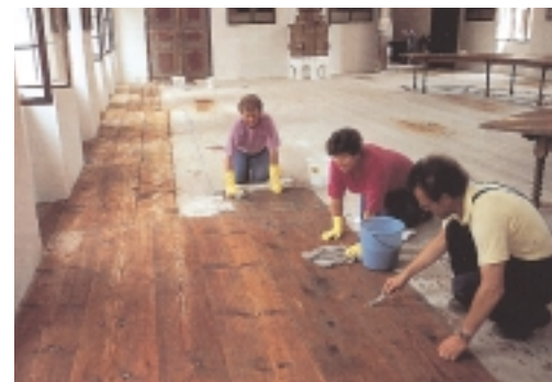
De opknopbeurt van een eiken vloer in een kasteel: reinigen met water en fijn wit zand (Herkomst foto: P. Nickl (Hrsg.), Parkett, München 1995)
