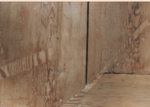
Detail van een gerepareerde grenen vloer. Voor het inboeten is gebruik gemaakt van stukjes van dezelfde houtsoort met de nerf in dezelfde richting als de planken (Foto Vlaardingerbroek & Wevers)
