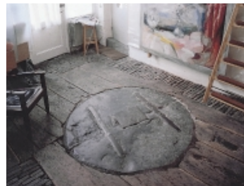
De vloer van een voormalige smidse in Deventer. Houten vloer met taps toelopende planken rondom een hardstenen plaat waarop de wagenwielen werden gelegd voor reparatie
