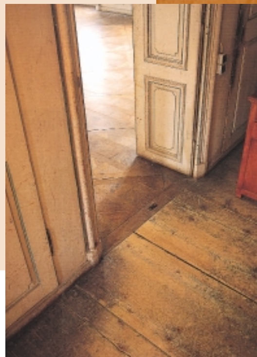
Twee historische houten vloeren: links een ‘rijke’ vloer: het zogenaamde Versaillesparket, rechts een ‘eenvoudige’ vloer met zeer brede planken. De vloeren dateren beide uit het eind van de 18de eeuw en hebben een vergelijkbare cultuur- historische waarde (Herkomst foto: P. Nickl (Hrsg.), Parkett, München 1995)
