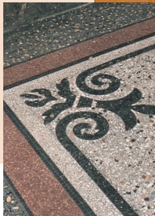
Hoekornament in de vorm van een Franse lelie van terrazzo in een terrazzoveld. De banden zijn van mozaïeksteentjes en terrazzo
