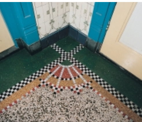
Een vloer in een woonhuis met een hoekornament en banden van mozaïeksteentjes en kleurig terrazzo
