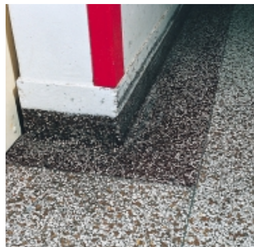
Detail van een vloer waarbij de overgang van de ene kleur naar de andere is benut om de dilatatie aan te brengen.
