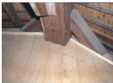
Leklatjes en lekgaten voor geleide afvoer van bluswater
