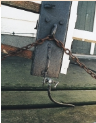
Bliksembeveiliging aan stalen molenroede als onderdeel van het brandbeveiligingsplan
