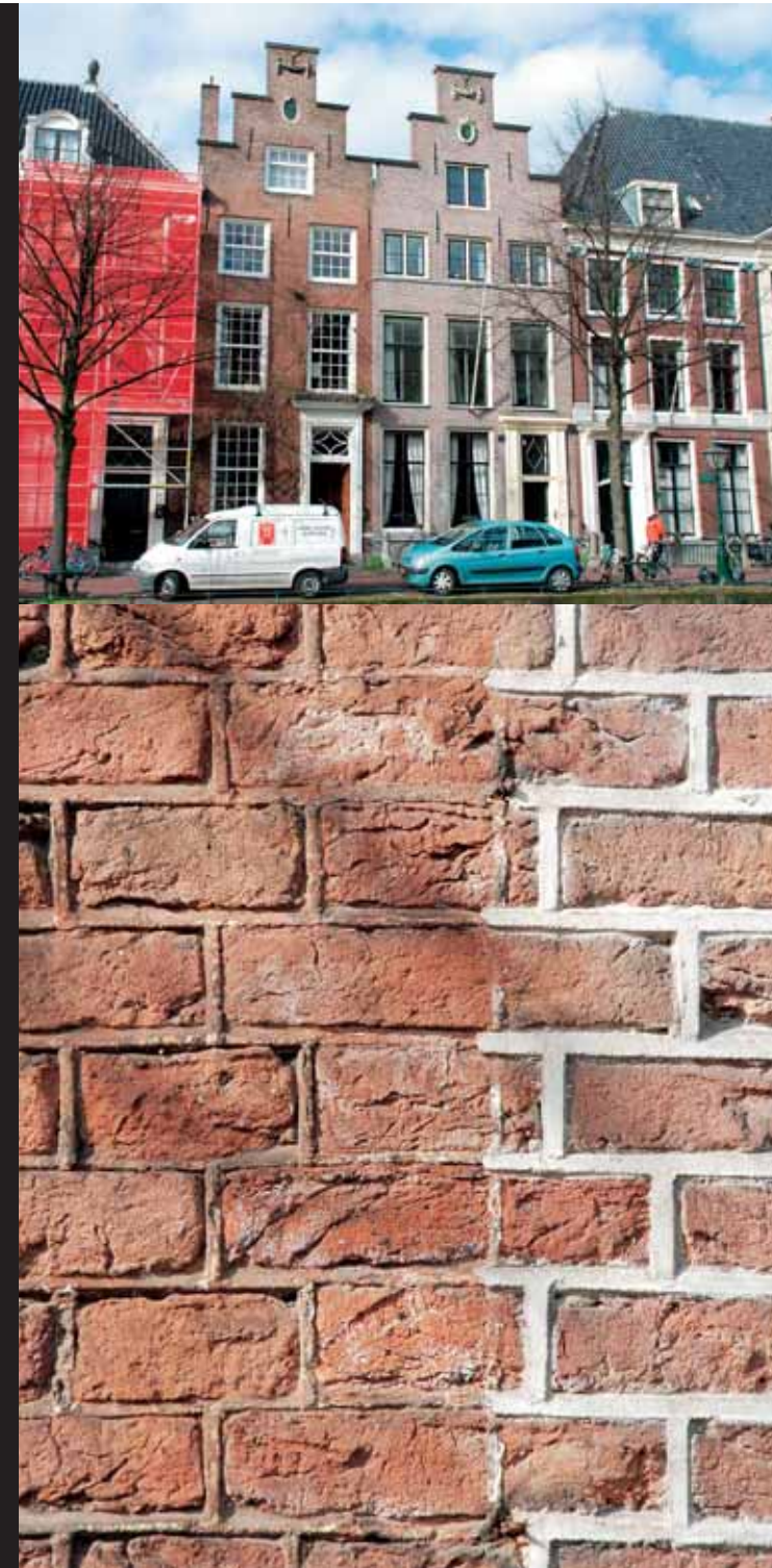
Twee vergelijkbare laatzeventiende-eeuwse gevels, waarvan de rechter opnieuw is gevoegd. De nieuwe voeg is lichter en breder, en ligt meer op de steen, waardoor die nadrukkelijker aanwezig is (foto's Taco Hermans)
