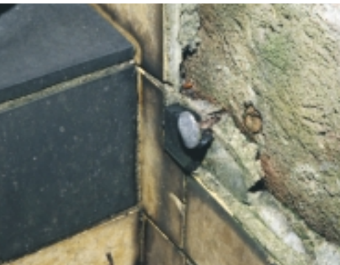
Detail van de roestende bevestiging van de eertijds aanwezige glazen tekstplaat
