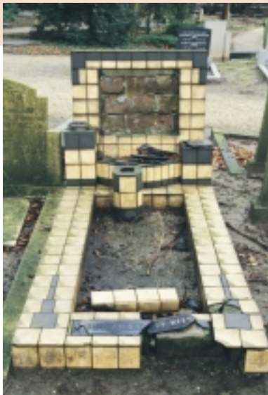
Beschadigd, betegeld grafteken met in scherven uiteengevallen glazen tekstplaat
