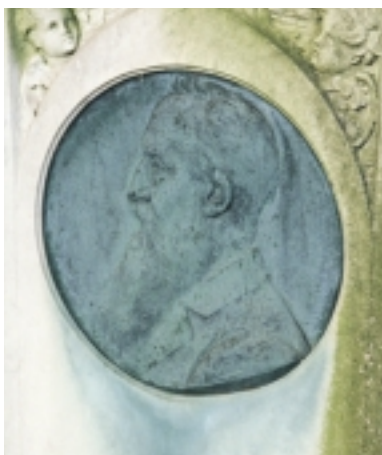
Bronzen plaquette. Afstromende corrosieproducten en algvorming veroorzaken verkleuring van de natuursteen
