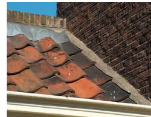
Het 'gemetselde' dak: de aansluiting met de muur is met specie afgedicht, maar aan de bovenzijde met lood, dat zich makkelijk in de vorm van de pannen laat kloppen
