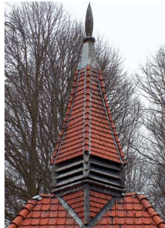
Voor het dekken van deze dakruiter zijn zelfs de kleine tuiles du Nord van het onderliggende dak niet geschikt. Daarom zijn leipannen gebruikt
