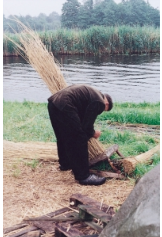
Nadat de rietstengels zijn vlak gestoten, wordt de bos gebonden
